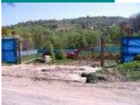
Prace przy sali gimnastycznej.
